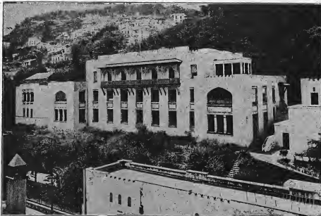
Institut Pasteur d'Alger. Bâtiment principal (fig. 6).
